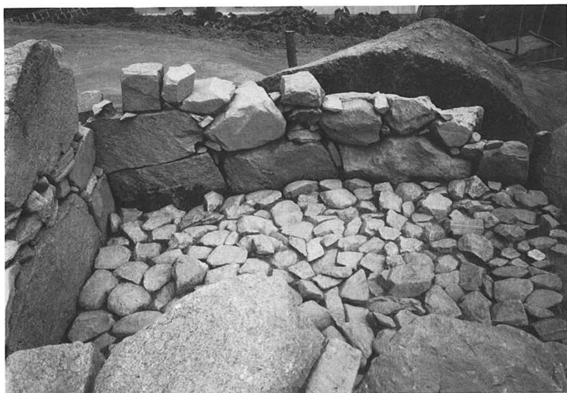
(2) 右側壁石積み状況
