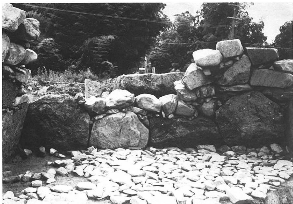
(2) 右側壁石積み状況
